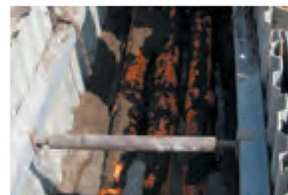
配管まわりの埋戻し
