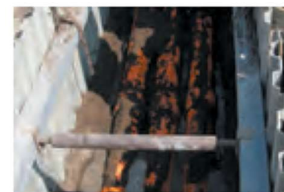
配管まわりの埋戻し
